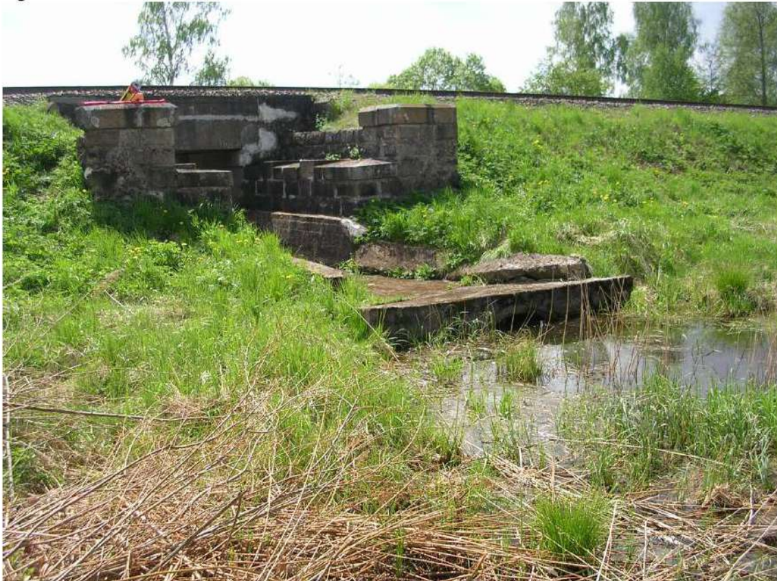
Pav. 2 Viaduko prieš kapitalinį remontą bendras vaizdas
